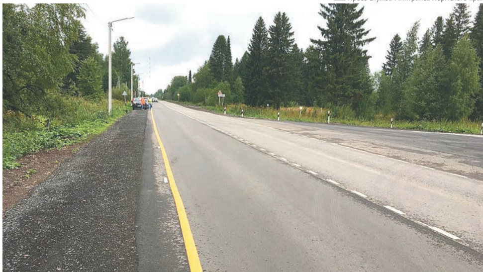
Участок дороги Сылва — Троица
