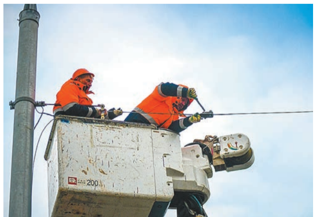
Монтаж контактной линии
