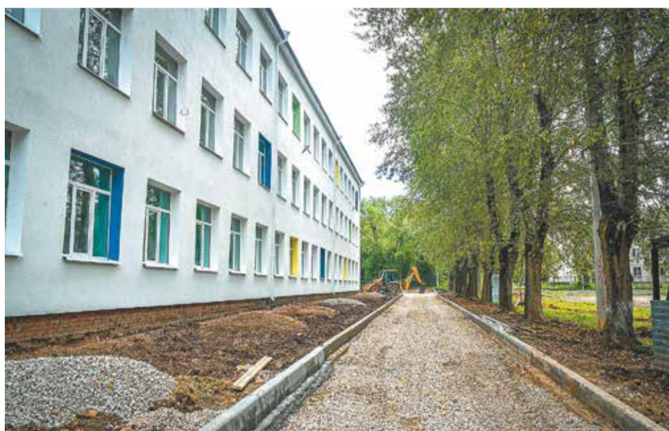
Благоустройство территории школы №118
