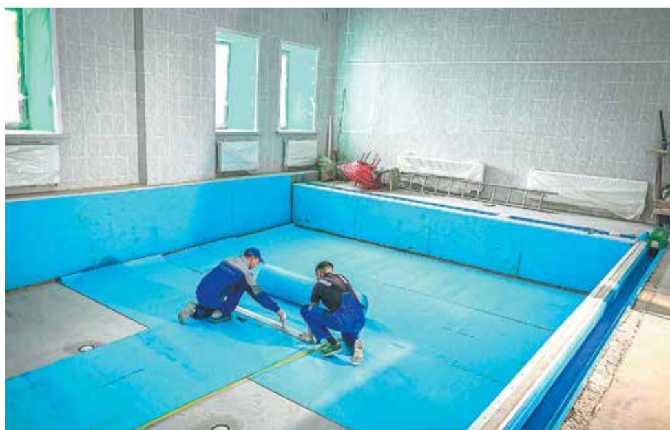
Ремонт бассейна в школе №28
